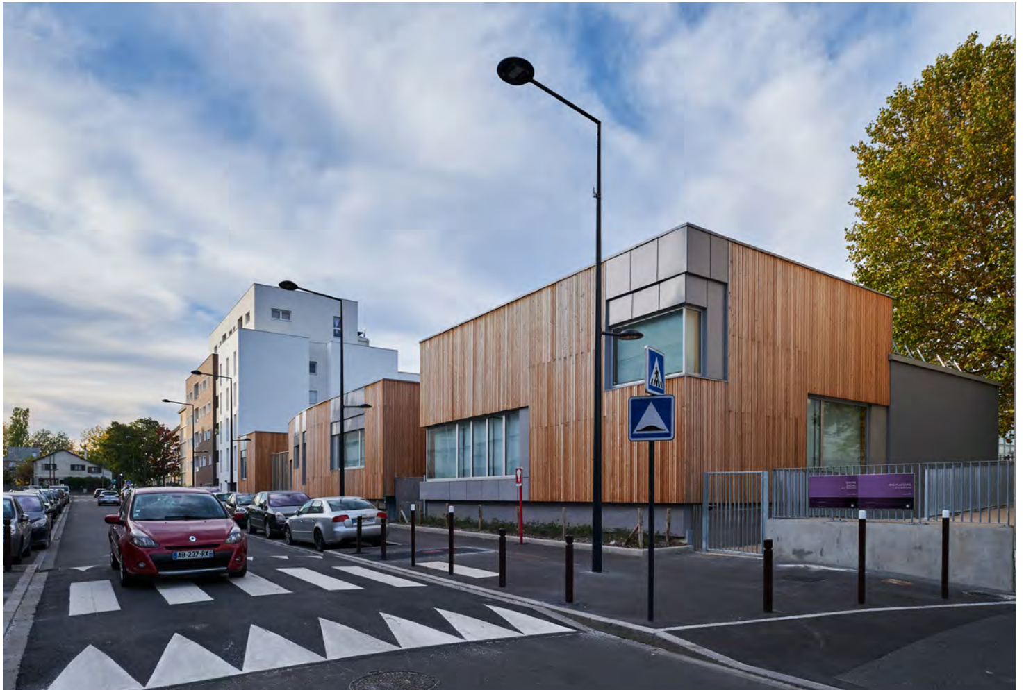
*le centre social réhabilité vu depuis la rue de Pontoise
