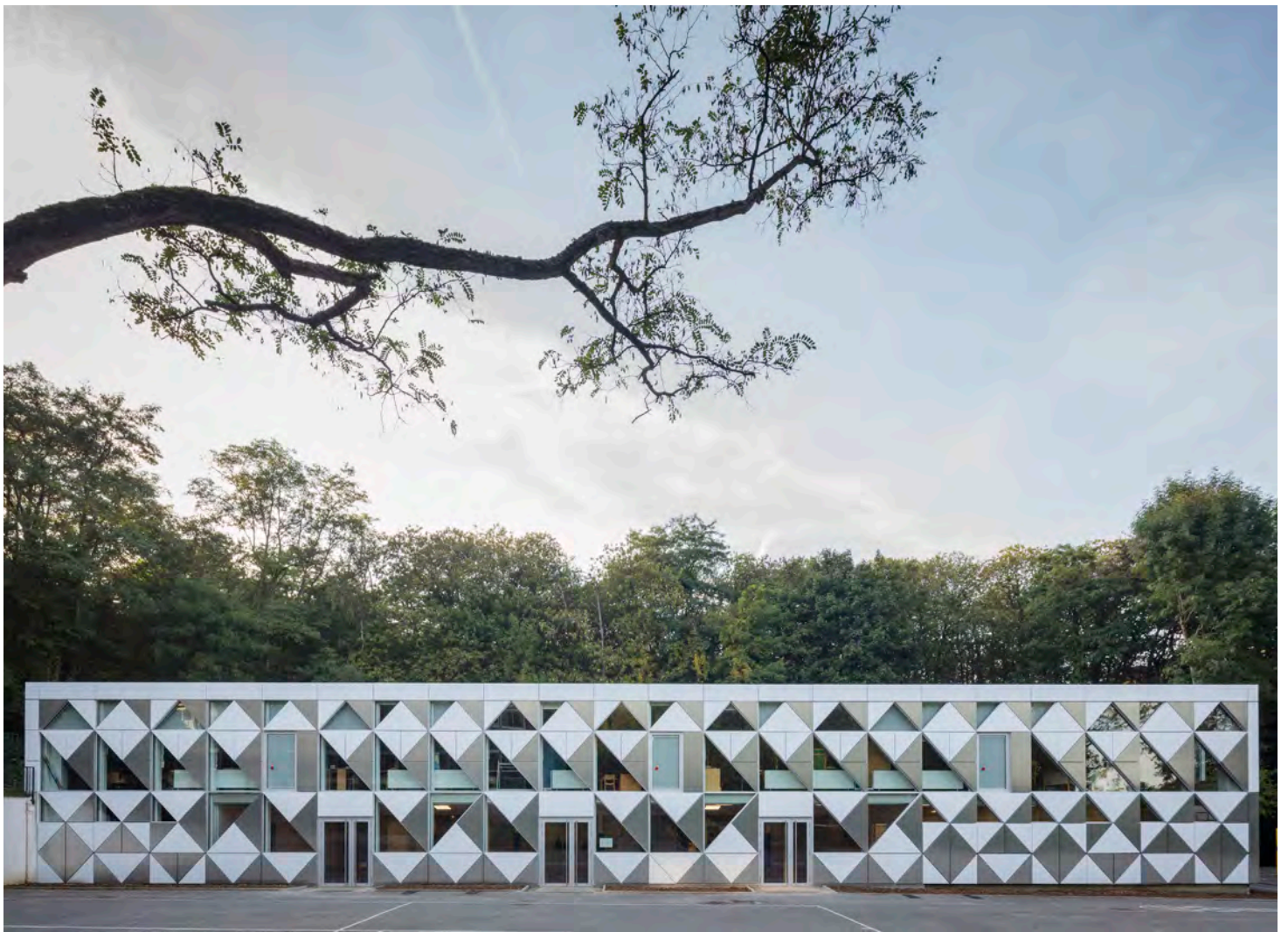
*vue frontale de l'opération réceptionnée *photo avant-projet
