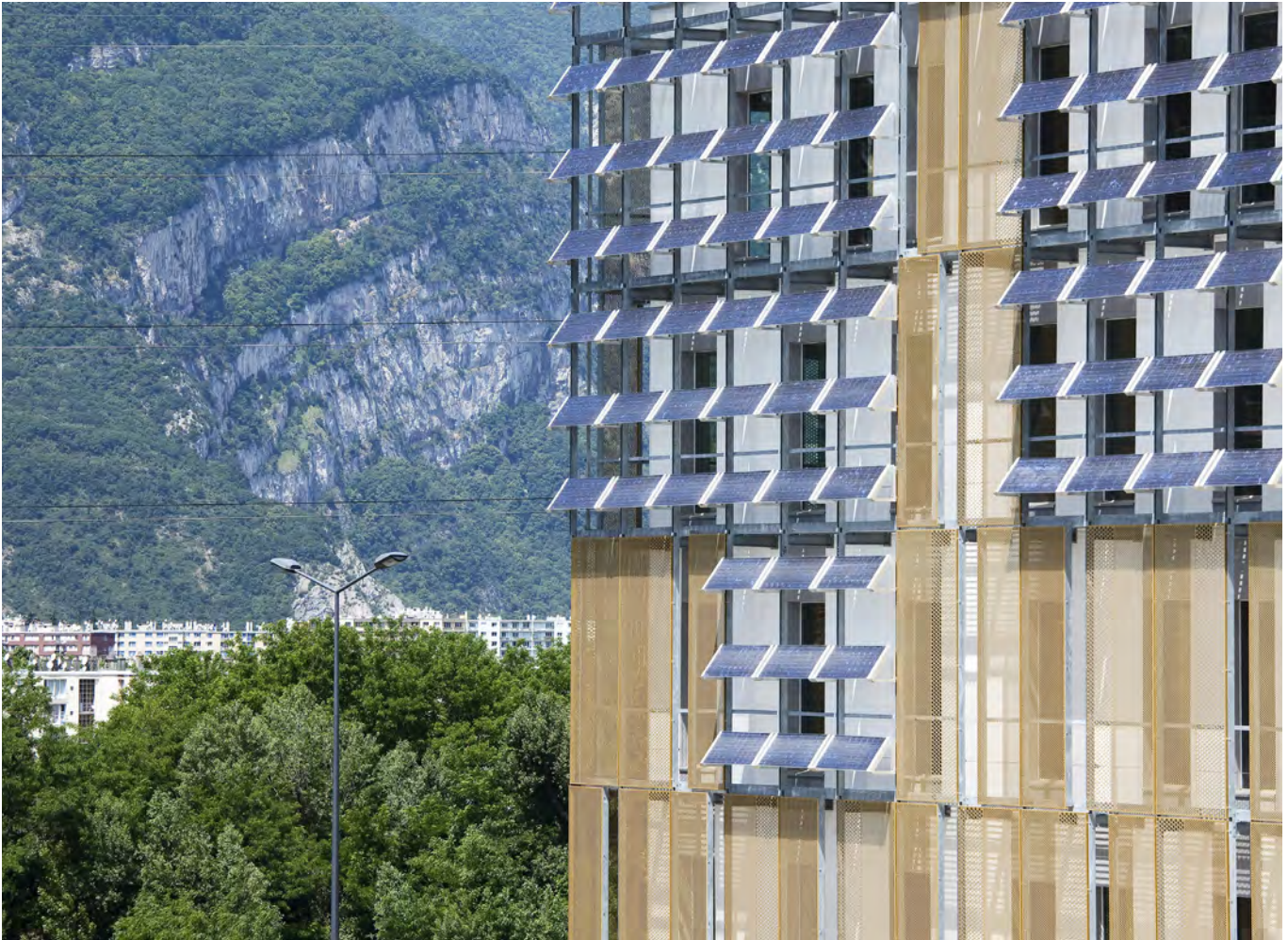
*détails des brise-soleil réalisés avec des panneaux photovoltaïques
