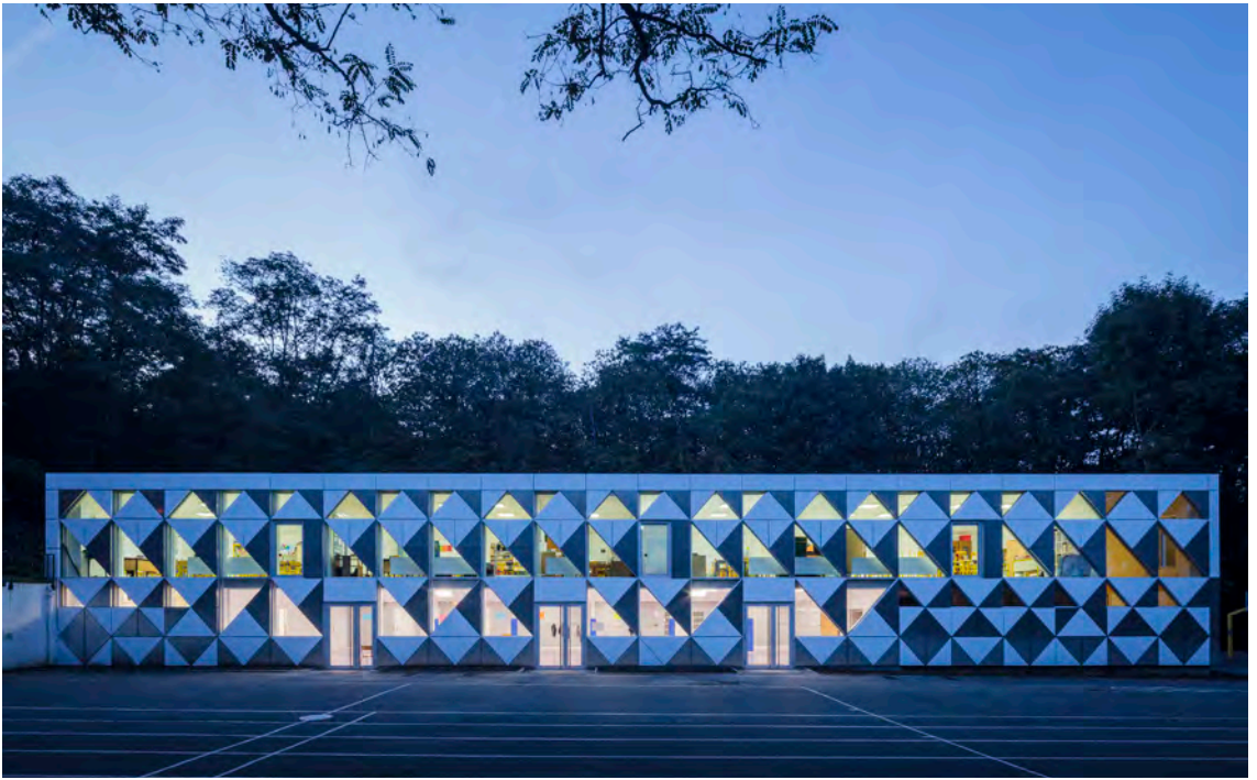
*vue frontale de la façade principale depuis la cours de récréation
