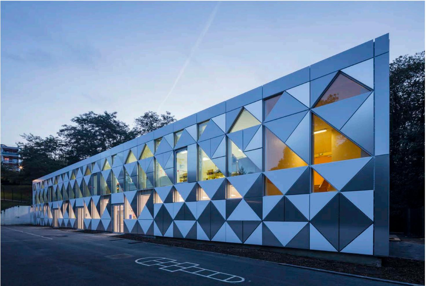
*\*photo de la façade principale de l'opération composée de panneaux en aluminium*
