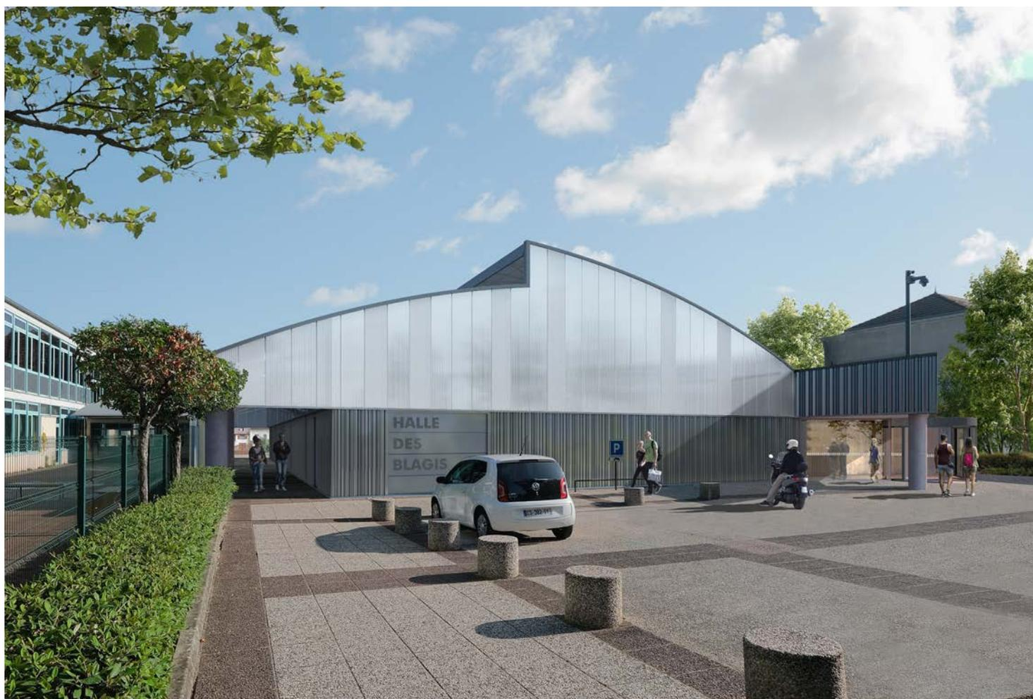
*\*Le socle sera surmonté d'une paroi réalisée avec une double peau en polycarbonate. Cela permettra de diffuser une lumière naturelle douce, diffuse et homogène dans la halle. De l'extérieur, de nuit, la halle s'illuminera affirmant sa présence dans la ville et son statut d'équipement public.*
