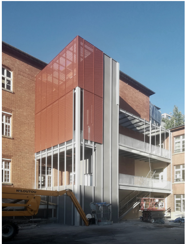
*Pose des panneaux d'habillage en métal déployé
