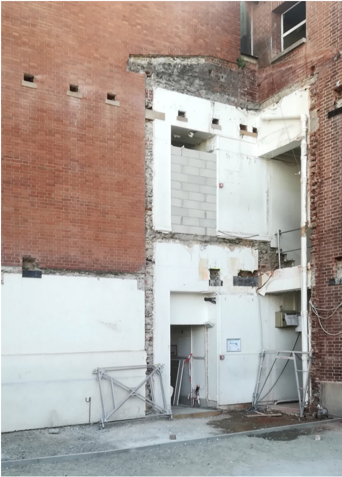
*Démolition de l'appendice entre les bâtiments B & C.
