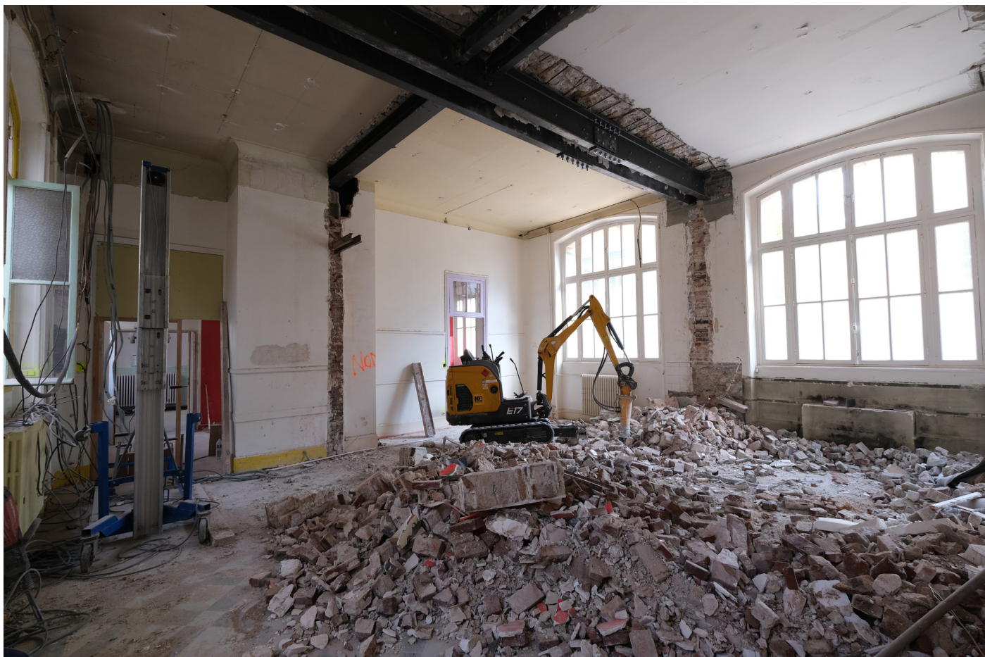
*Démolition de murs porteurs pour créer le nouveau réfectoire
