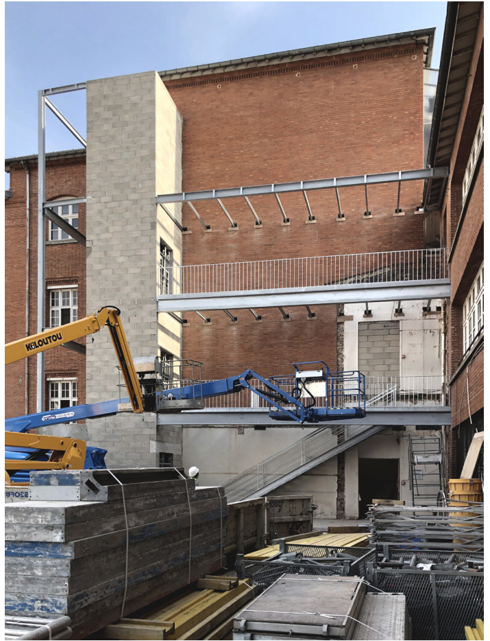
*Élévation de la gaine ascenseur et début pose charpente métallique
