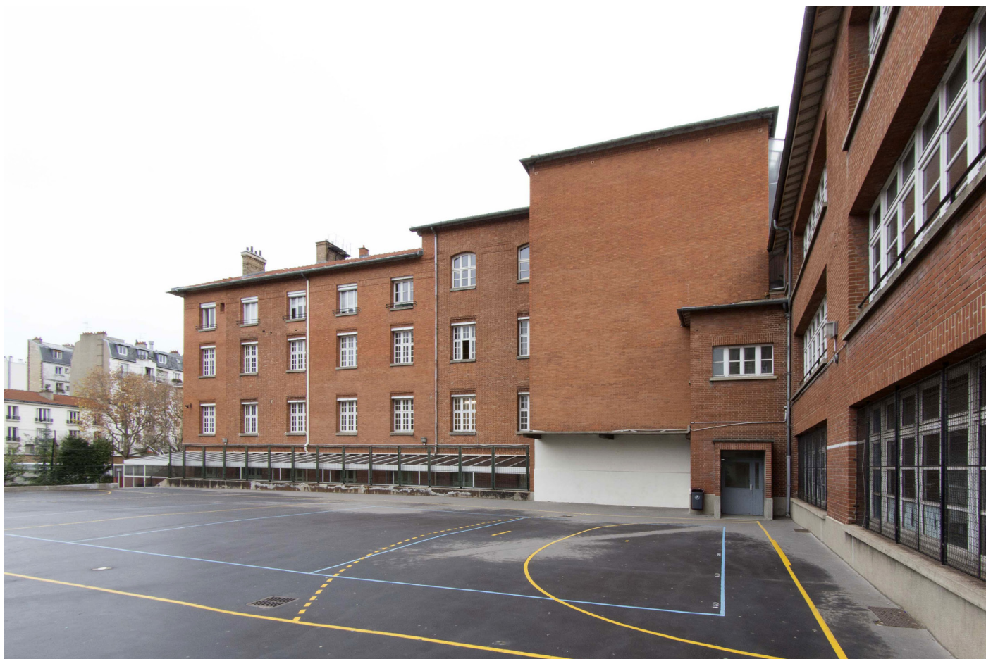
*La cour haute avant les travaux
