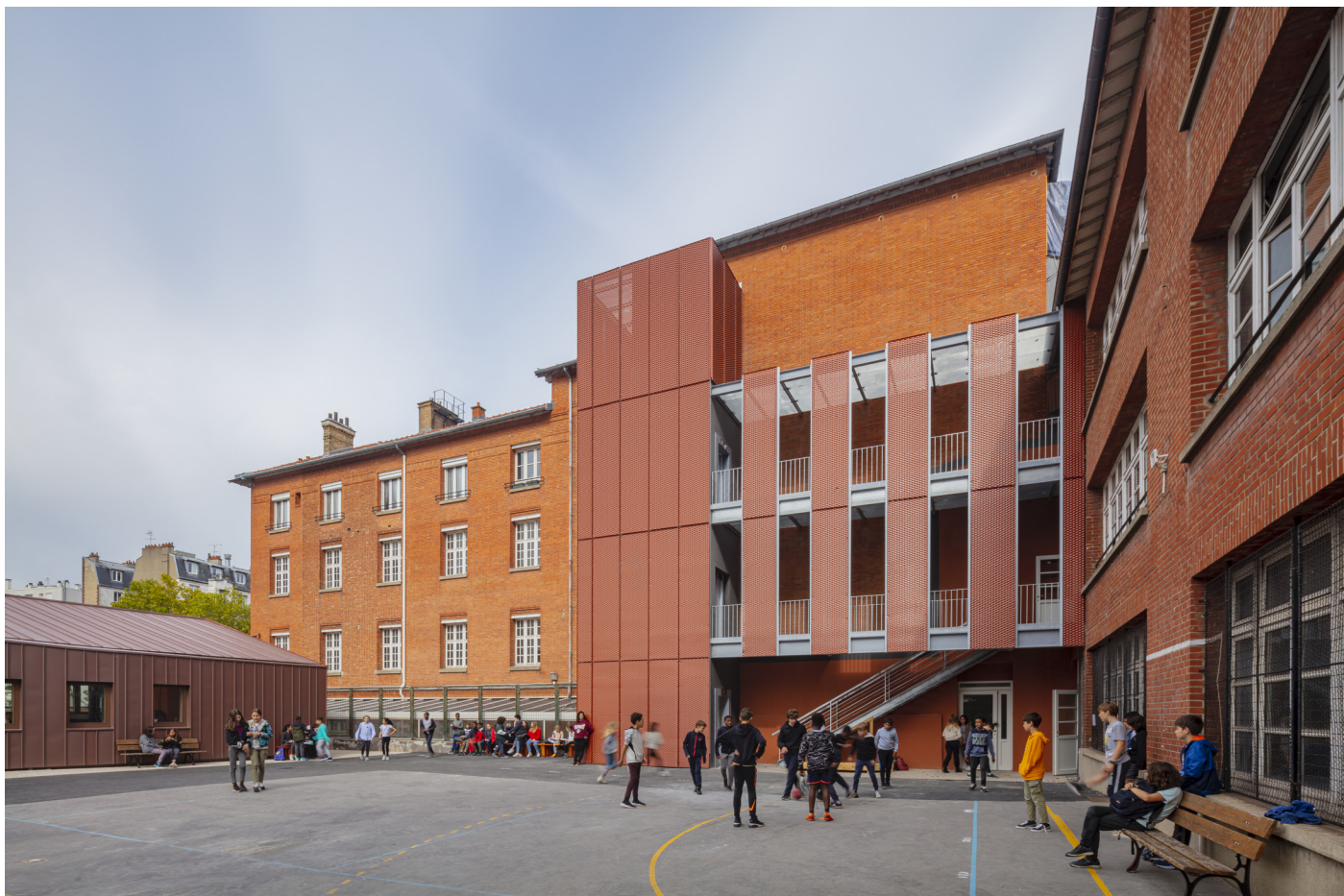
*Création d'un ascenseur et de passerelles pour la mise en accessibilité PMR de l'établissement
